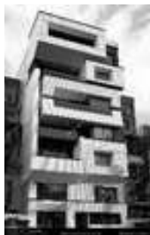
آیارتمان مسکونی، در شمال
